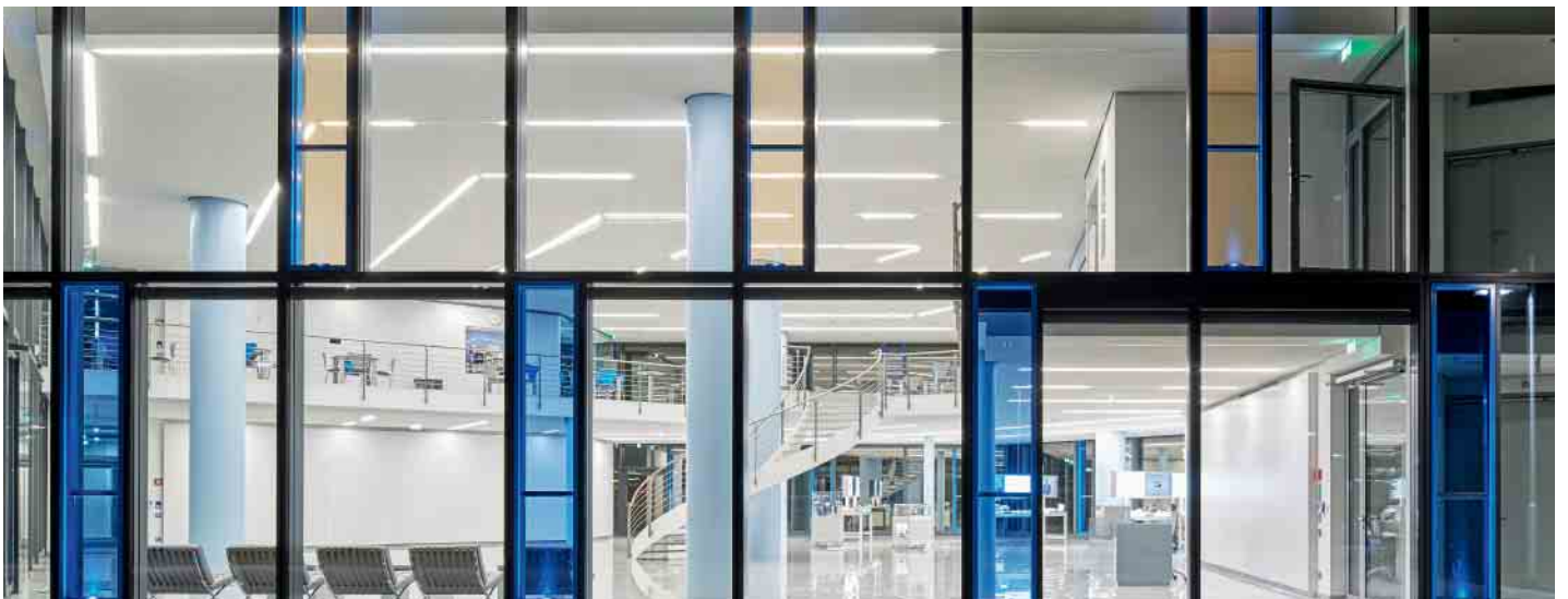
Schüco LightSkin als fassadenintegrierte Lösung in der Schüco Elementfassade USC 65 Schüco LightSkin as a façade-integrated solution in the Schüco Unitised Façade USC 65
